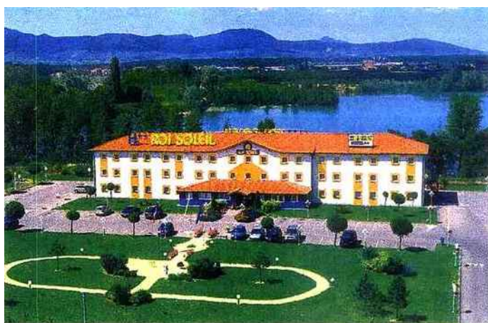
La chaîne possède sa propre équipe qui assure la construction modulaire de ses établissements
